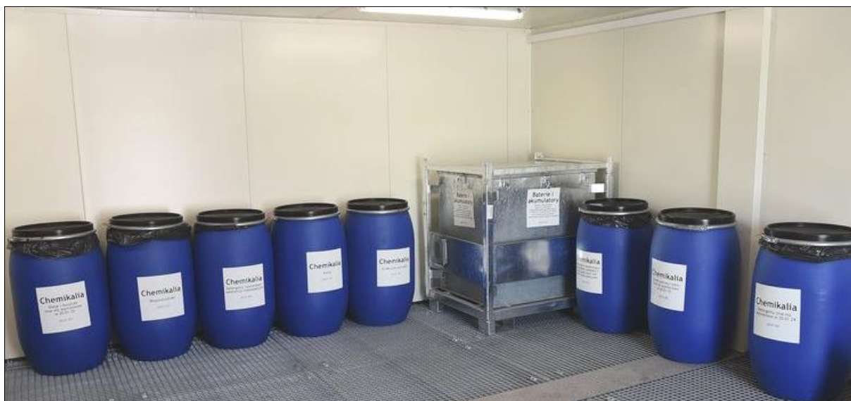
Ryc. 13. Propozycja wykonania podłogi magazynu ZSEE
